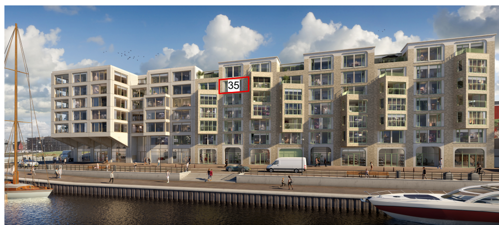
gevelaanzicht bouwdeel ZECC
