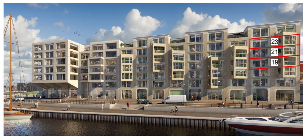
gevelaanzicht bouwdeel ZECC
