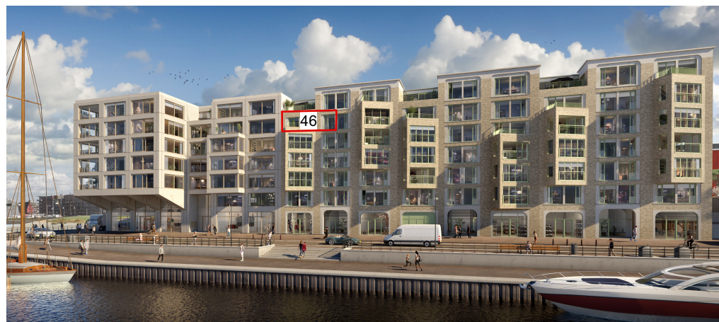
gevelaanzicht bouwdeel ZECC
