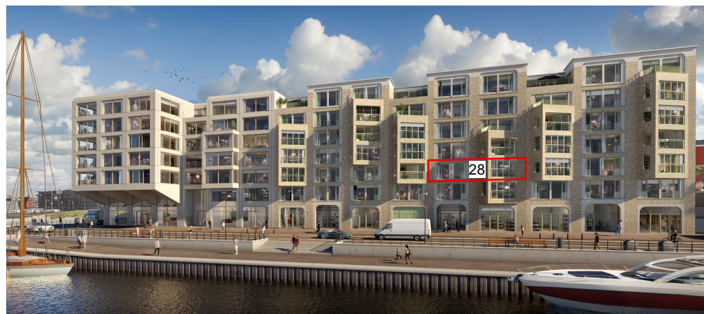
gevelaanzicht bouwdeel ZECC
