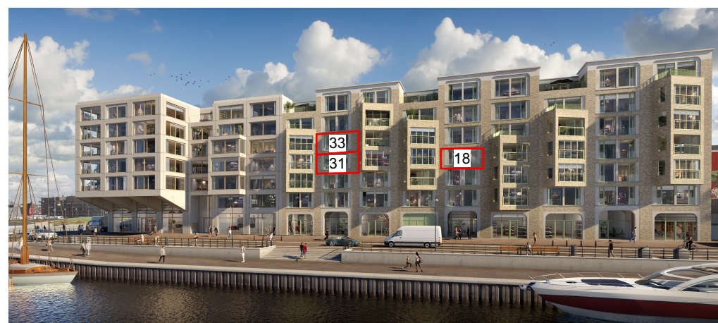
gevelaanzicht bouwdeel ZECC
