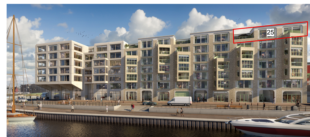
gevelaanzicht bouwdeel ZECC
